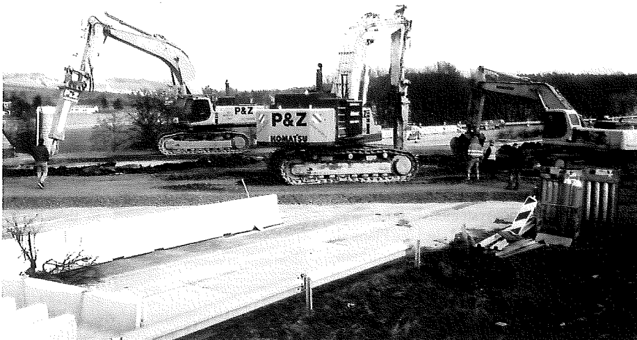
Gleitwände, die zum Schutz der Gegenfahrbahn auf dem Mittelstreifen platziert werden, sind aus Massiv-Beton und bieten mehr Sicherheit als herkömmliche Leitplanken.
